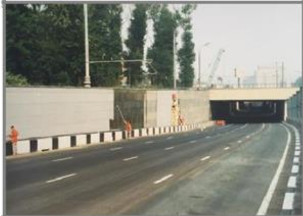
Защита и гидроизоляция бетона ТТК, Нахимовский тоннель г. Москва.
