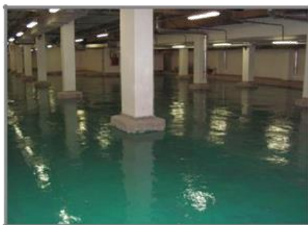
Полимерные тонкослойные полы подземного паркинга, Рязанский пр-т, г. Москва.
