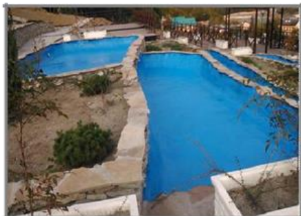
Гидроизоляция каскада водопадов, санаторий «Беларусь», г. Сочи, п. Красная Поляна.
