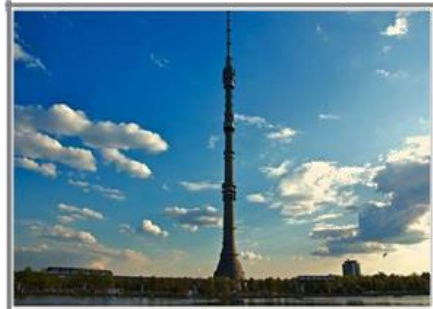
Ремонт и упрочнение бетона внутренней поверхности Останкинской телебашни после пожара, г. Москва.
