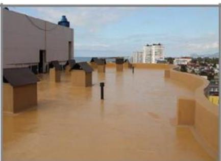
Комплексный ремонт и мастичная гидроизоляция кровли гостиницы, г. Адлер.
