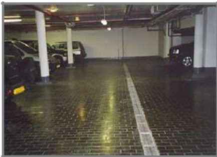
Обеспыливание полов паркинга банковского хранилища, г. Москва.
