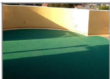
Защитное наполненное кварцевым песком покрытие террасной кровли, г. Краснодар.
