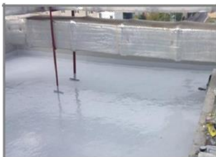
Комплексный ремонт и гидроизоляция кровли МКЦ «Кристалл», г. Краснодар.
